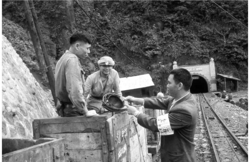
圖 14 「海底大斜坑」採「雙軌制」（雙向式伏地索道）直通海底，這是台灣從沒有過的。- 張偉郎 提供
